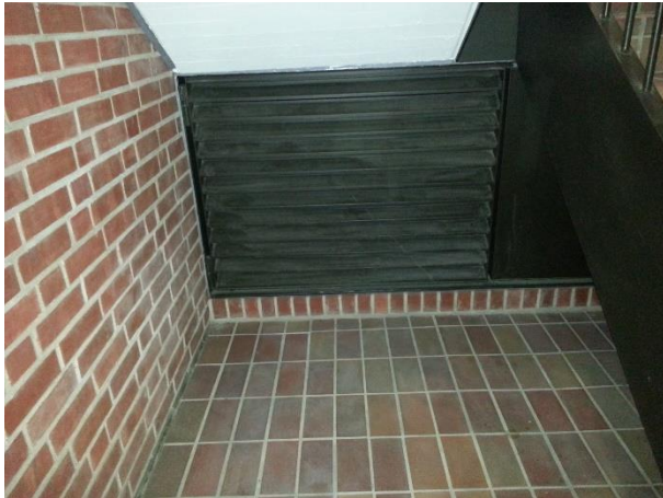
Abbildung 24: Bestehende Zuluftöffnung zum Treppenraum
