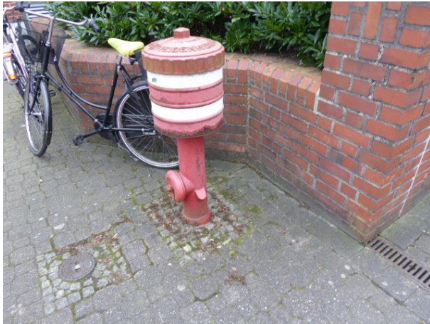
Abbildung 9: Bestehender Überflurhydrant im Außenbereich
