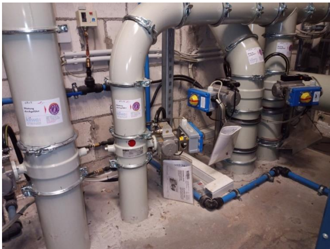
Abbildung 28: Absauganlage 4. OG mit Absperrvorrichtungen
