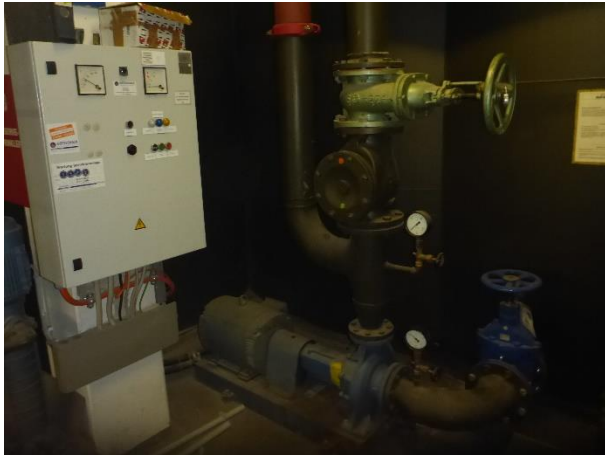
Abbildung 30: Bestehende Sprinklerpumpe
